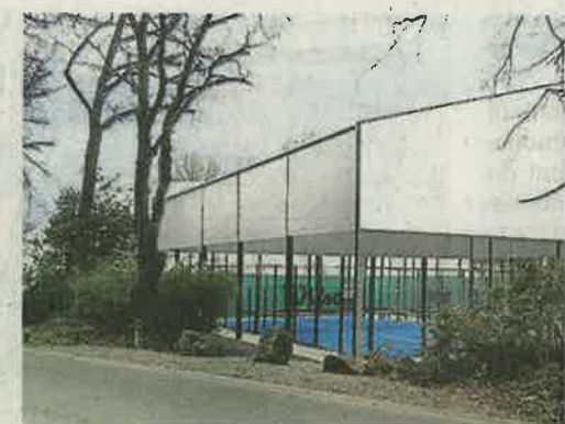
Les deux terrains seront bientôt à l'abri de la pluie.
